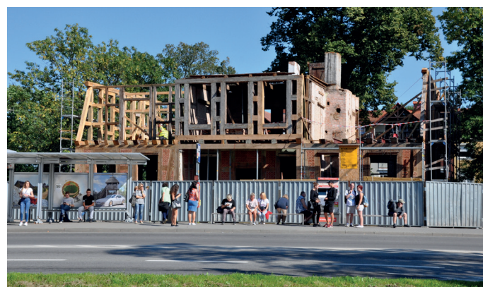
Remont budynku przy ul. Krótkiej 6
