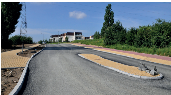
Budowa ul. Strzeleckiego
