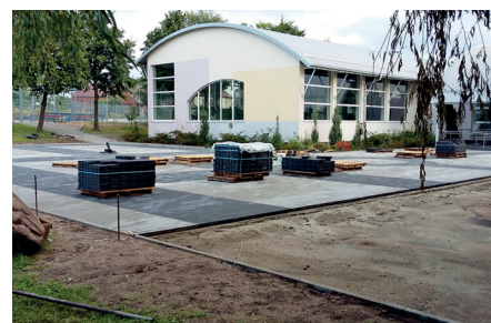
Budowa miasteczka ruchu drogowego przy SP nr 3
