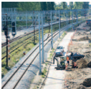
Budowa ul. Podmiejskiej
