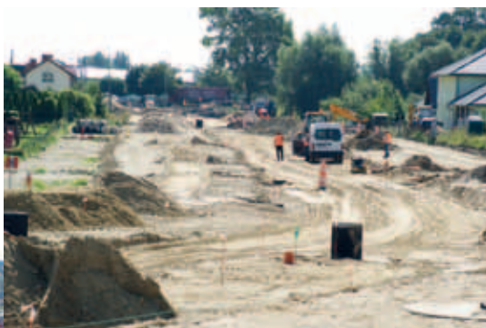
Budowa ul. PCK
