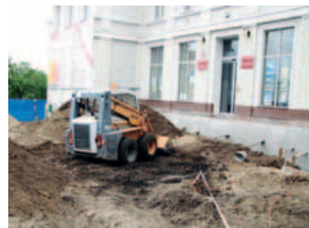
Prace remontowe przy schodach
