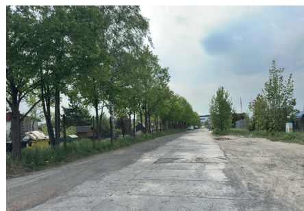
Ul. Tczewska przed realizacją
