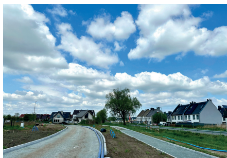
Ul. Jaśminowa w trakcie realizacji
