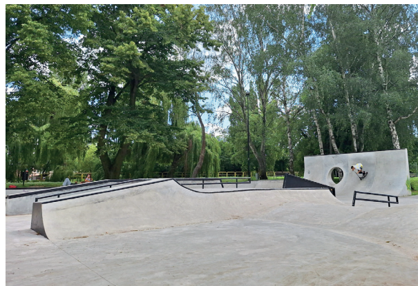
Skatepark po zakończeniu budowy
