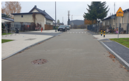
Przebudowa ulic Banacha i Przy Torze w Pruszczu Gdańskim
