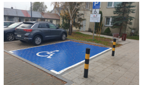
Przebudowa ulic Banacha i Przy Torze w Pruszczu Gdańskim
