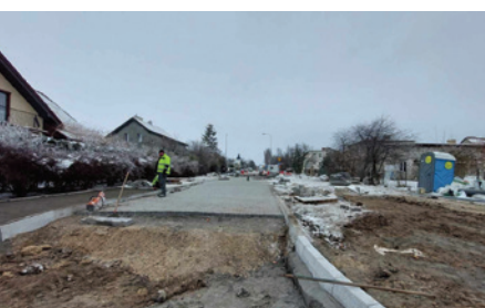
Przebudowa ul. Reymonta
