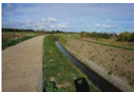
Przebudowa rowu melioracyjnego w rejonie Przy Torze. (fot. Adam Moczulski)
