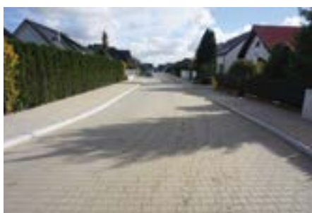
Przebudowana ulica Sidły wraz z kanalizacją deszczową. (fot. Adam Moczulski)
