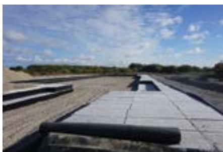
Budowa zbiornika w rejonie Przy Torze: etap I i II. (fot. Adam Moczulski)
