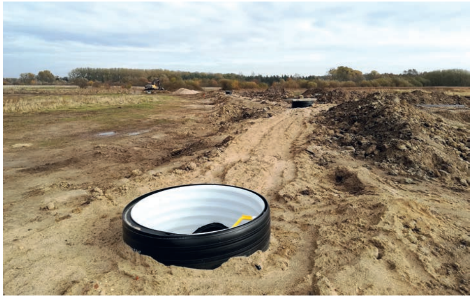
Budowa sieci kanalizacji deszczowej w rejonie Przy Torze.
