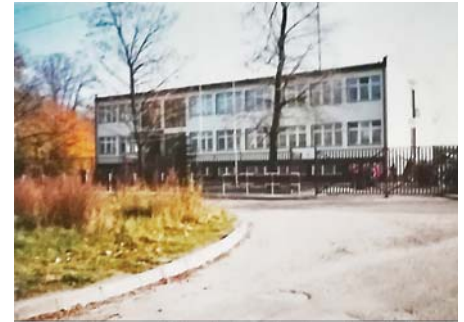
Zdjęcie przedstawiające budynek szkoły na ul. Westerplatte.
