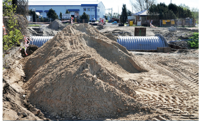
Budowa przepustu przy ul. Nowowiejskiego
