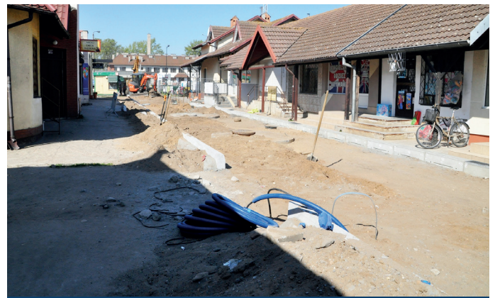
Budowa ciągu pieszego przy dworcu PKP
