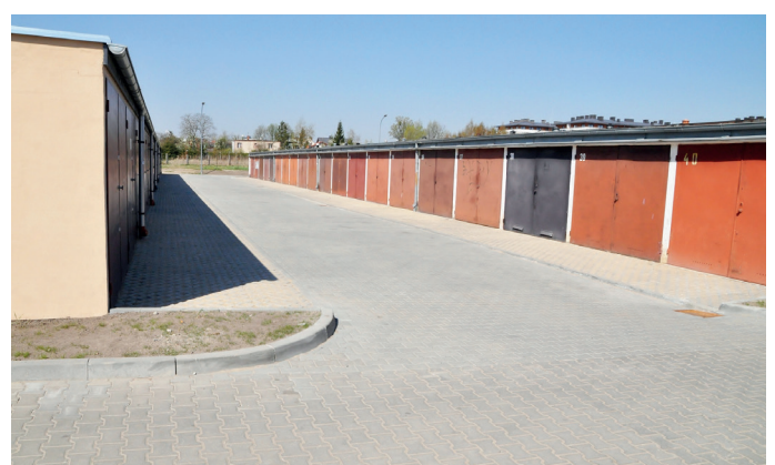
Utwardzenie drogi przy garażach przy ul. Spokojnej
