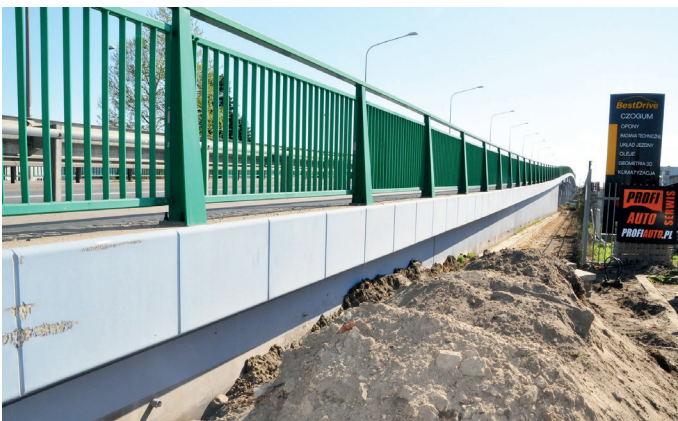
Budowa ścieżki rowerowej przy ul. Podmiejskiej
