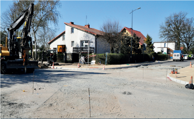
Budowa ul. Słowackiego (inwestycja powiatowa dofinansowana przez miasto)
