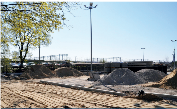
Budowa parkingu Park & Ride przy ul. Dworcowej
