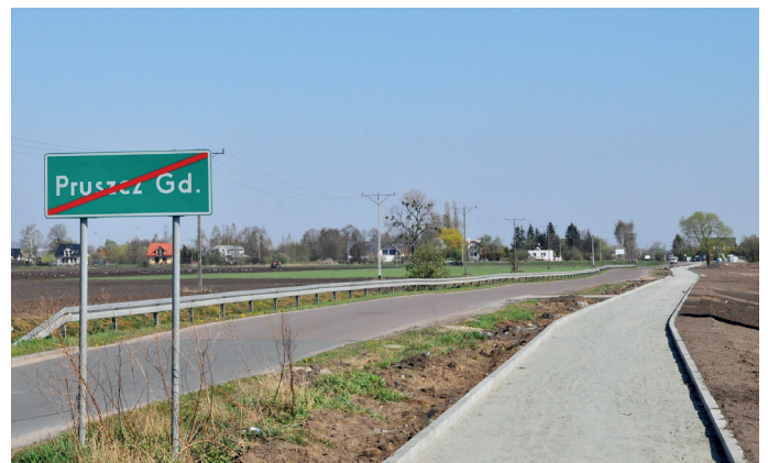
Budowa ścieżki rowerowej Pruszcz Gd. - Radunica (inwestycja powiatowa)
