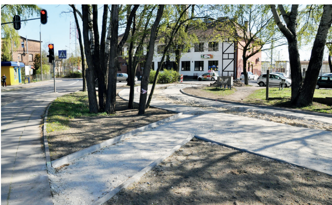
Budowa ścieżki pieszo-rowerowej z centrum miasta do dworca PKP
