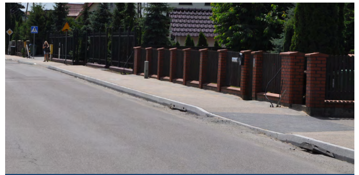
Chodnik przy ul. Sienkiewicza
