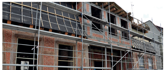
Budynek przy ul. Krótkiej 6
