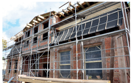
Budynek przy ul. Krótkiej 6 w trakcie remontu
