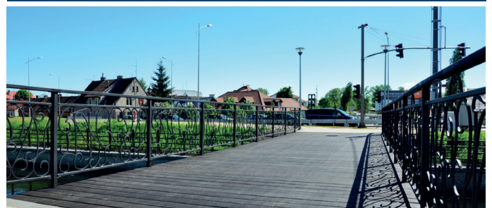
Kładka na Kanale Raduni
