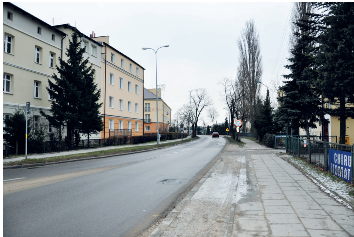
ul. Powstańców Warszawy przed przebudową
