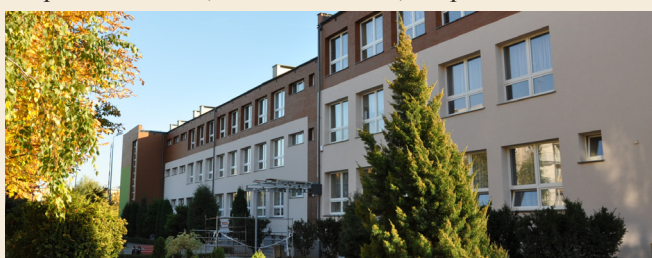
Elewacja ZS nr 2 (fot. M. Pycka)
