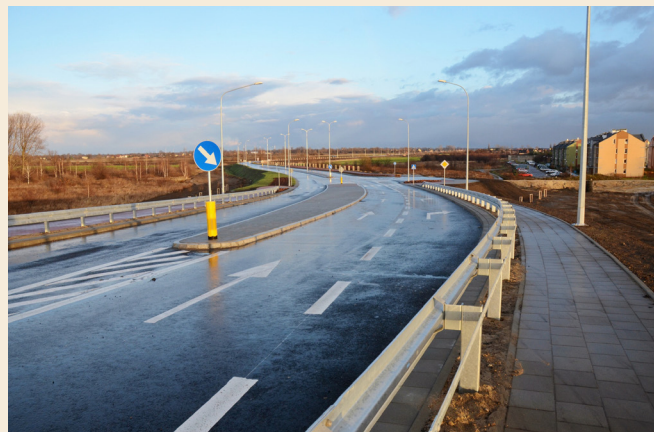
Obwodnica Pruszcza Gdańskiego (fot. J. Swis)
