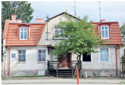
Budynek przy ul. Grunwaldzkiej 31
