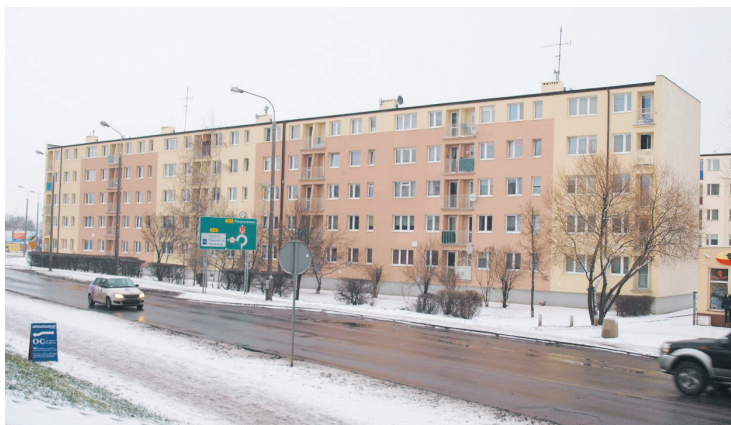
Nowa elewacja budynku przy ul. Żwirki i Wigury
