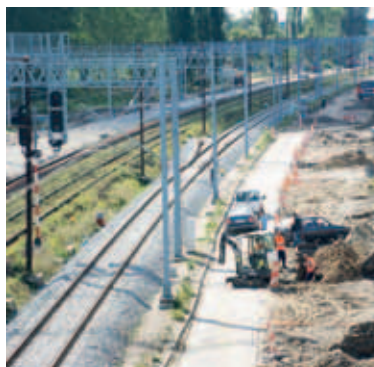
Budowa ul. Podmiejskiej
