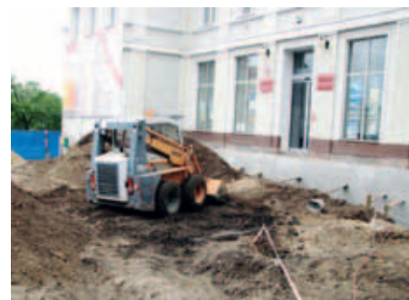
Prace remontowe przy schodach
