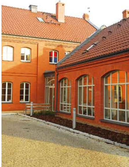
Zrewitalizowany budynek Wozowni
