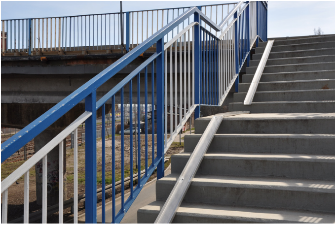
Prowadnice rowerowe na wiadukcie
