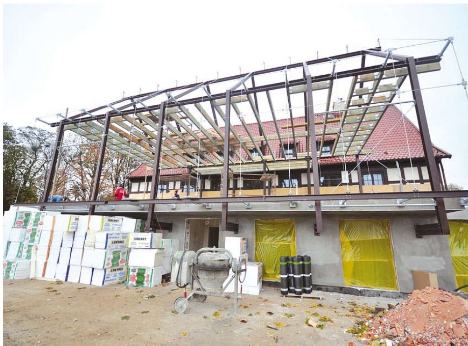
Rozbudowa budynku CKiS
